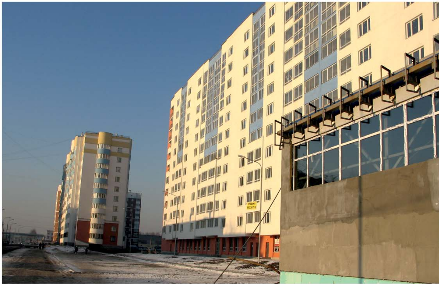
Вид по ул. Пехотинцев в процессе строительства
